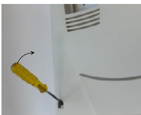
Rimuovi il Pannello di Controllo Del DCS800, se presente. Premere i blocchi per rimuovere il coperchio
